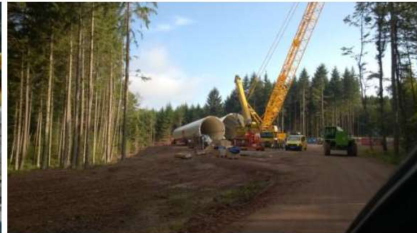
Baustelle Ottweiler-Bexbach (Saarland)
